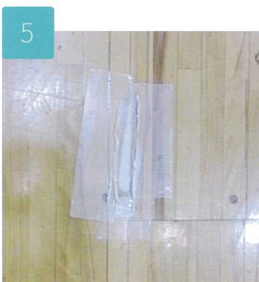
5 パテ硬化後、 サンドペーパーで平にする
