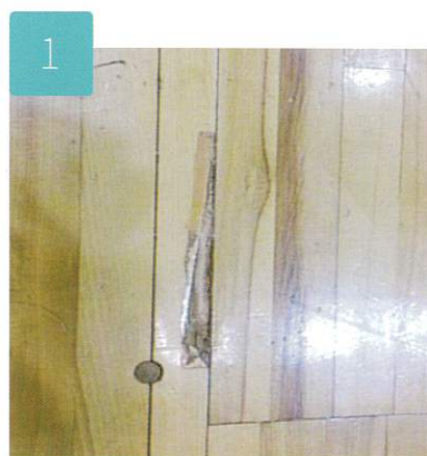
1 剥離部分のササクレを カッター等で除去した後、 サンドペーパーで平にする
