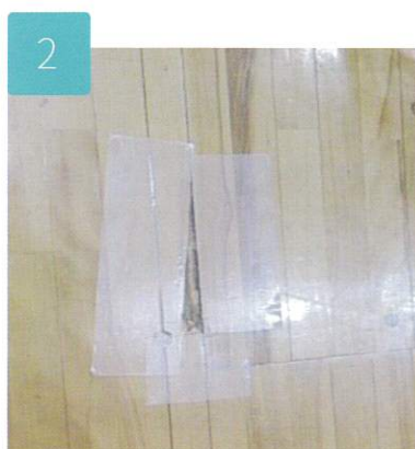
2 剥離部分以外にパテが つかない様にテープで養生
