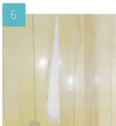
6 補修テープを貼って 修繕完了
