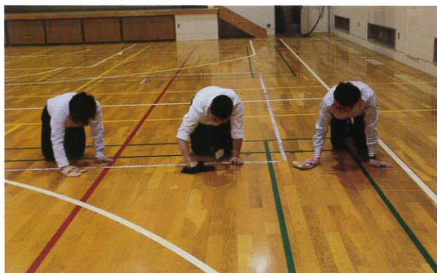
担当範囲を定め、近い距離で点検を実施している例
